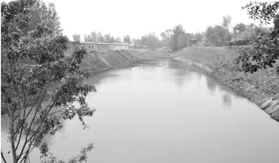
寿张镇魏台村的坑塘淤泥已清理完毕,坑塘边栽植上了小树苗,坑塘旁的道路即将铺设。
