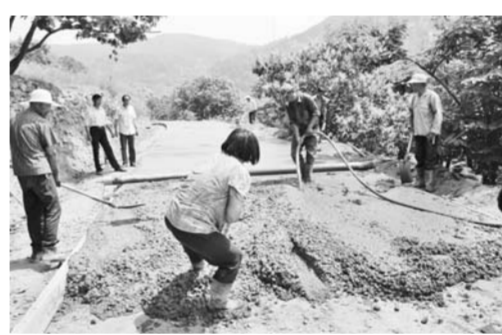
双层振动施工。
