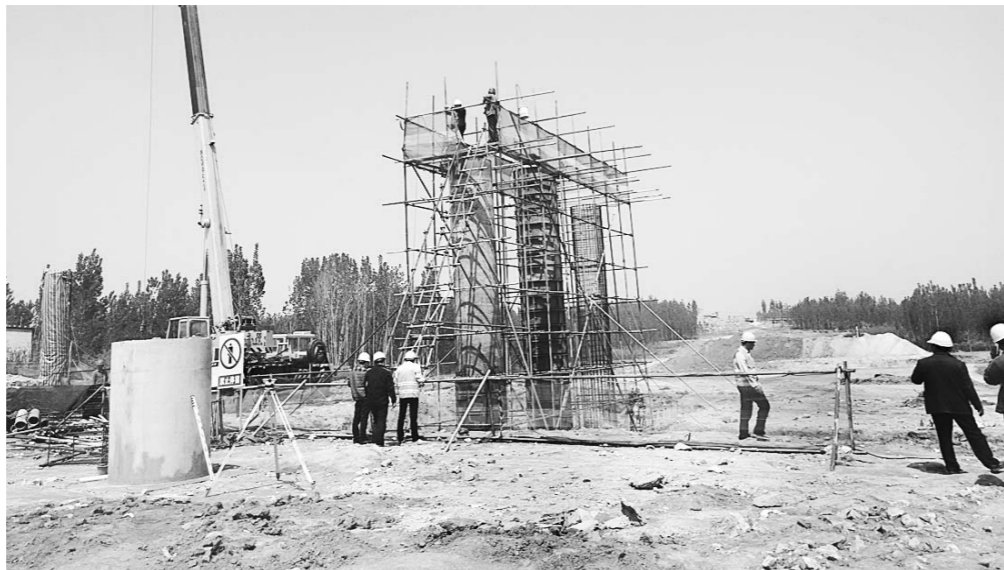
▲4月22日，工人们正在104国道改线工程施工现场紧张忙碌着。
