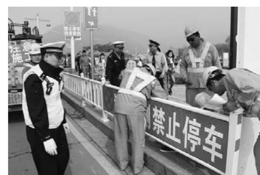
▲工作人员正在天外村新增便民指示牌。
