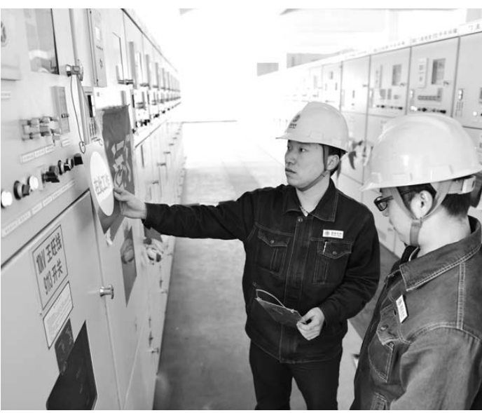
为了更好地校验10千伏开关柜内的开关设备和保护装置,4月20日,博兴供电公司组织人员对110千伏村魏变电站进行检修和预试,确保客户在度夏期间用电无忧。
