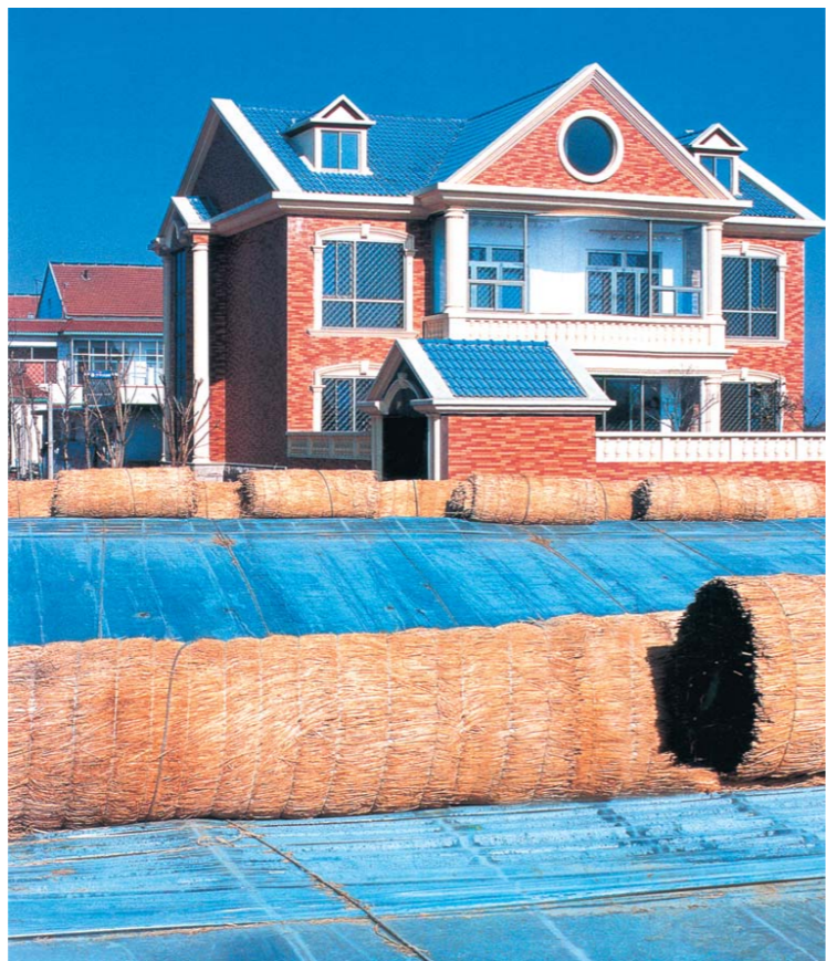
建设在大棚种植区旁的农民住宅新区。
