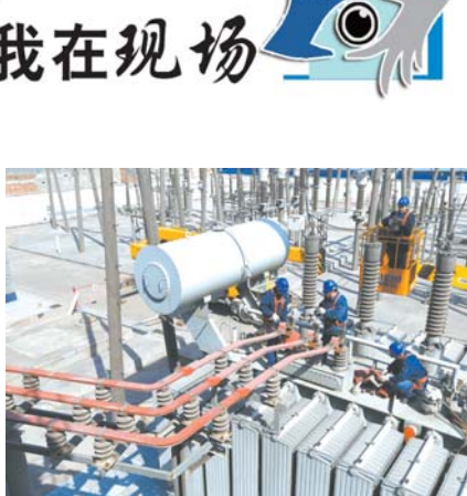
济南供电公司变电检修人员正在对110千伏匡山变电站2号主变进行检修。
