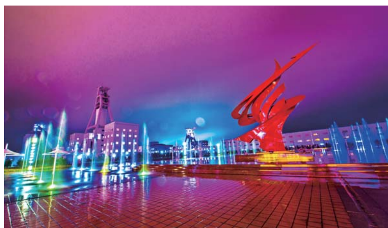
△位于内蒙古的淄矿集团巴彦高勒矿井
