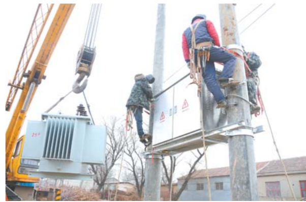
□李海涛 报道 连日来,国网天津供电公司的18支网架突击队600余人发挥兵团作战优势,倒排工期加班加点,全力攻坚工程进度,保障了春节期间的可靠供电。
