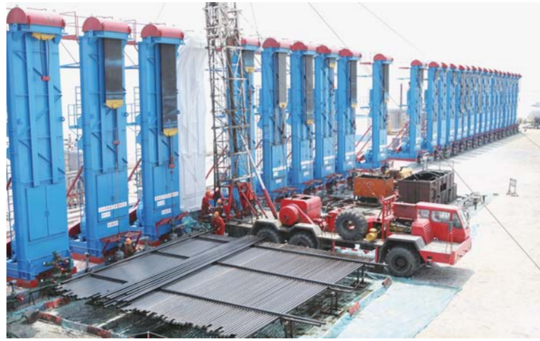
△胜利油田员工正在对智能化抽油机进行施工作业。
