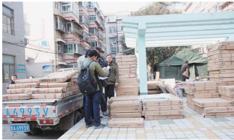
△县西巷社区工作人员正在协助施工人员给居民安装暖气
