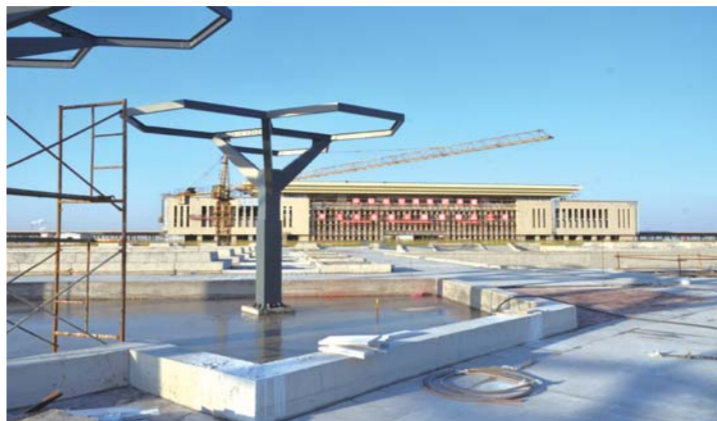
△德大铁路滨州站高铁客运枢纽中心加紧建设
