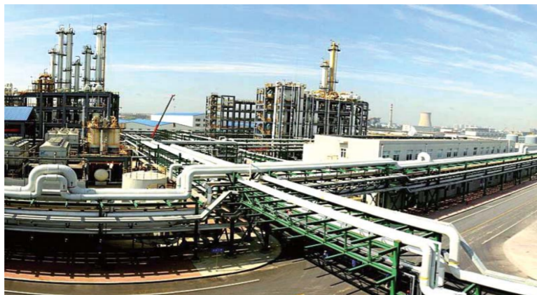
△即将竣工投产的滨化整体搬迁及综合技改项目
