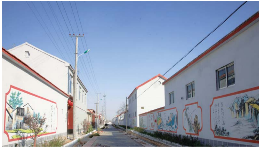
△农村环境综合整治后滨城区杨柳雪镇邓家村新貌
