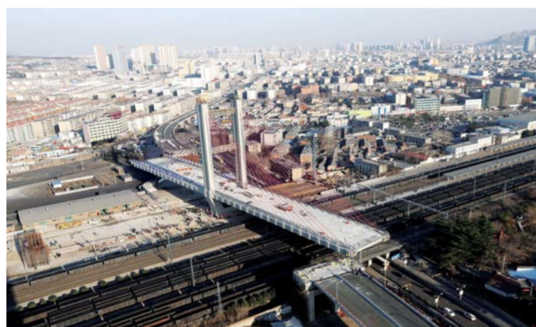
△世界最重的上跨京沪铁路转体立交桥完美合龙
