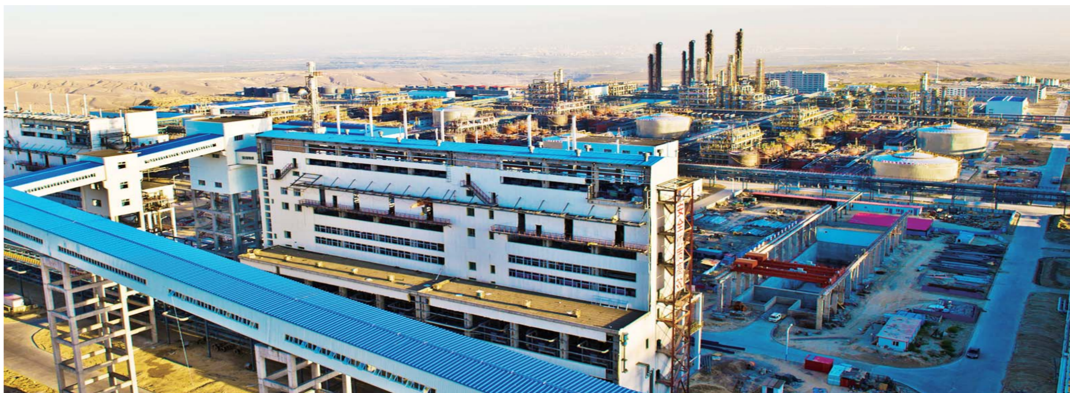
△山东能源新矿集团伊犁新天煤化工20亿立方米煤制天然气项目
