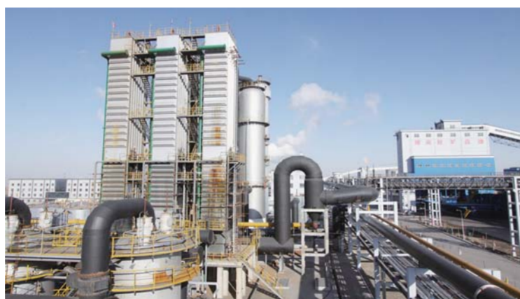
△世界首个焦炉煤气制天然气项目——山东能源新矿内蒙古恒坤化工
