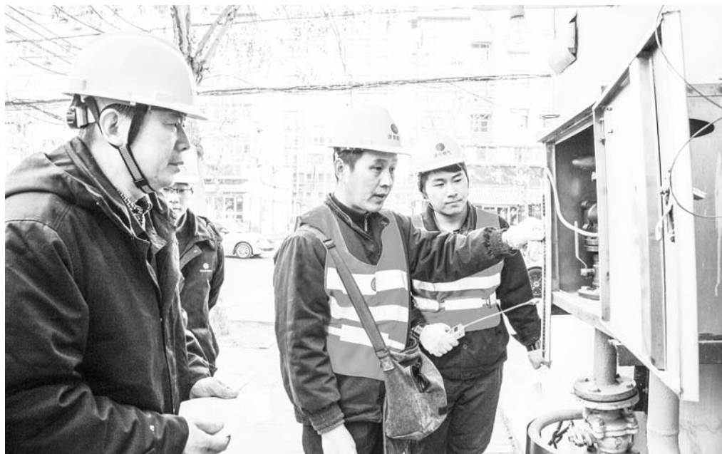
1月13日，山东济华燃气工作人员在测量燃气调压器压力是否正常。
