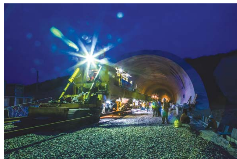
△青荣城际车山隧道长轨推送作业
