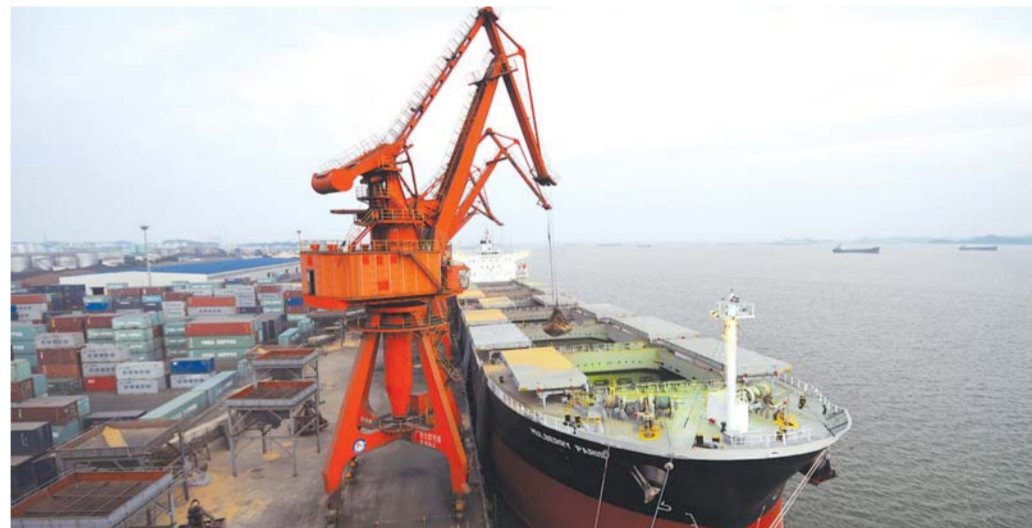
△山东高速集团投入20亿元参与潍坊港建设开发。
