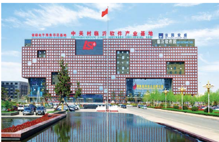
△中关村临沂软件产业基地
