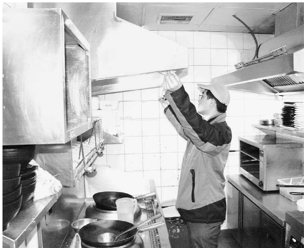
11月20日，济南市环保局工作人员对餐饮企业的油烟净化设备进行检查。
