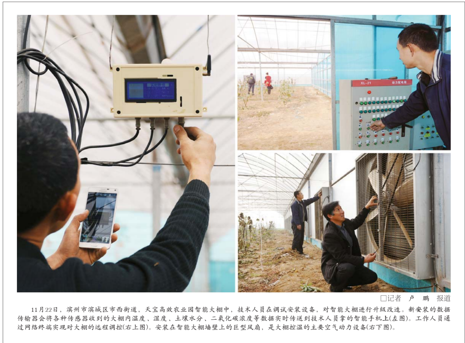
□ 记者 卢鹏 报道 11月22日，滨州市滨城区市西街道，天宝高效农业园智能大棚中，技术人员在调试安装设备，对智能大棚进行升级改造。新安装的数据传输器会将各种传感器收到的大棚内温度、湿度、土壤水分、二氧化碳浓度等数据实时传送到技术人员拿的智能手机上（左图）。工作人员通过网络终端实现对大棚的远程调控（右上图）。安装在智能大棚墙壁上的巨型风扇，是大棚控温的主要空气动力设备（右下图）。
