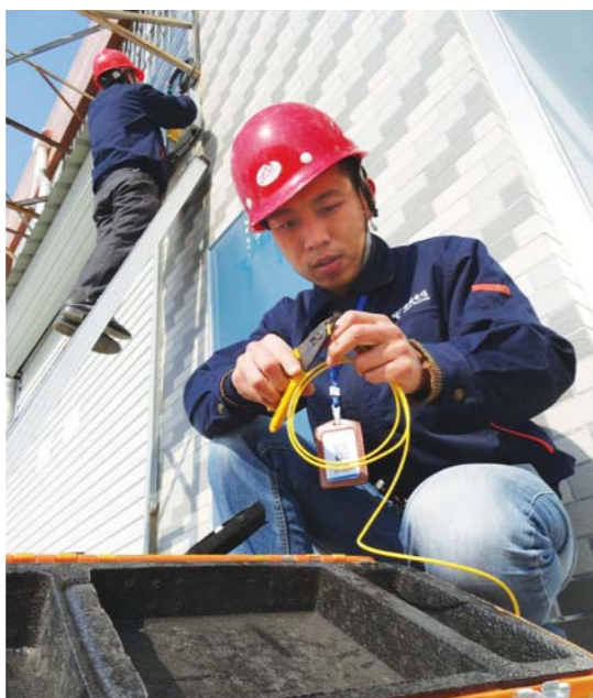
△山东电信员工进行农村光纤宽带基础设施建设施工
