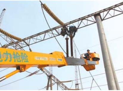
工作人员正在更换绝缘子
