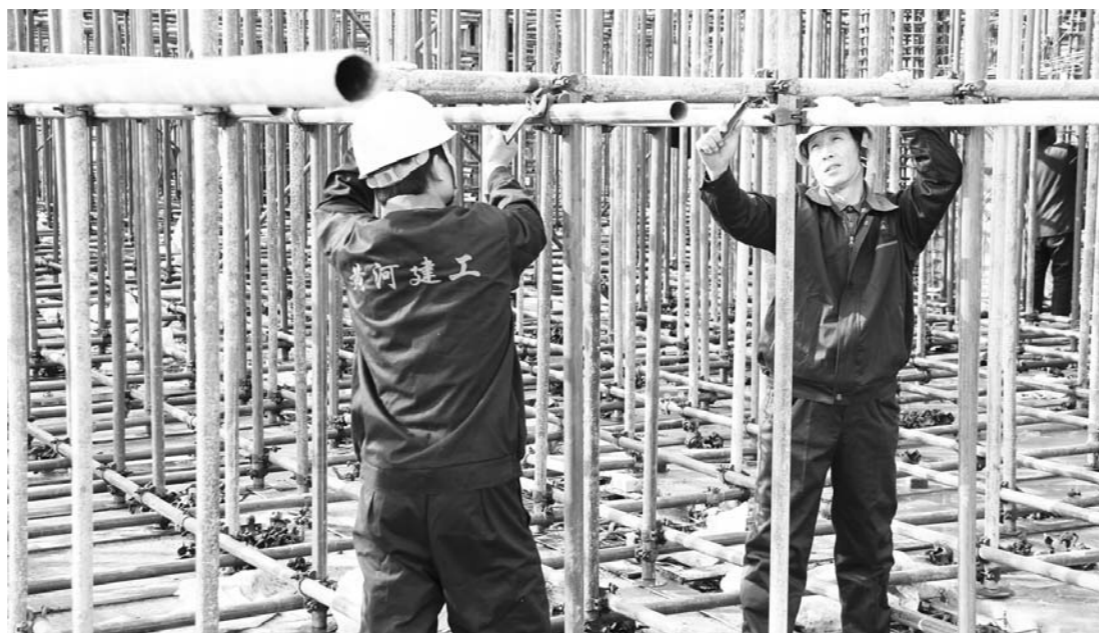
□ 杨淑栋 报道 11月6日,在黄河建工的千乘湖人员掩蔽应急指挥中心施工现场,工人正在进行建筑施工。
