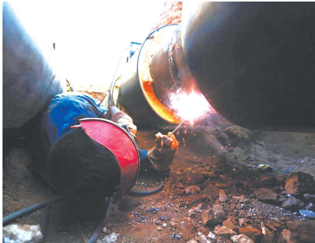
寿光东城供暖管线改造进入收尾阶段。
