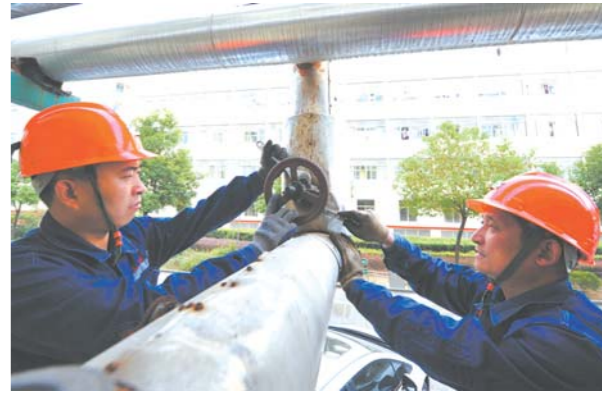
□耿玉鸣 报道 山东能源龙矿集团高煤公司提前制定供暖方案，加强对整个供暖系统、设施等进行检修，确保冬季能够正常供暖。图为检修人员正在检修供暖管道。
