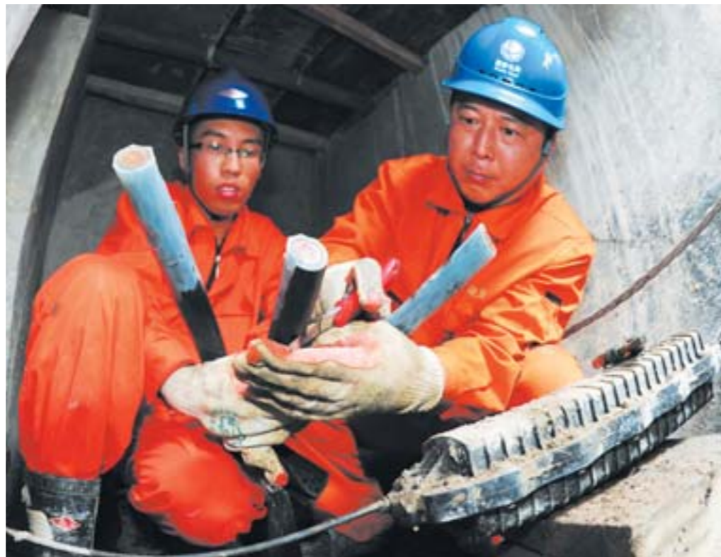
国网泰安供电公司员工进行配网工程改造施工。
