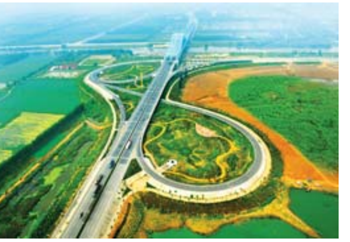
△京杭运河特大桥
