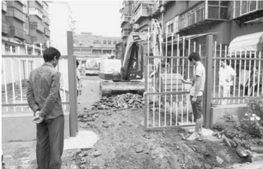
施工人员在长安社区新建围墙、封闭门。(资料图)
