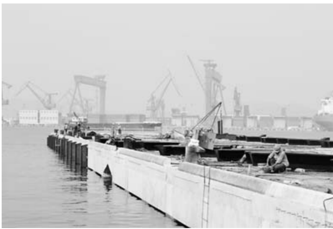
□薄克国 报道 ▲工作人员正在为码头安装橡胶护舷。
