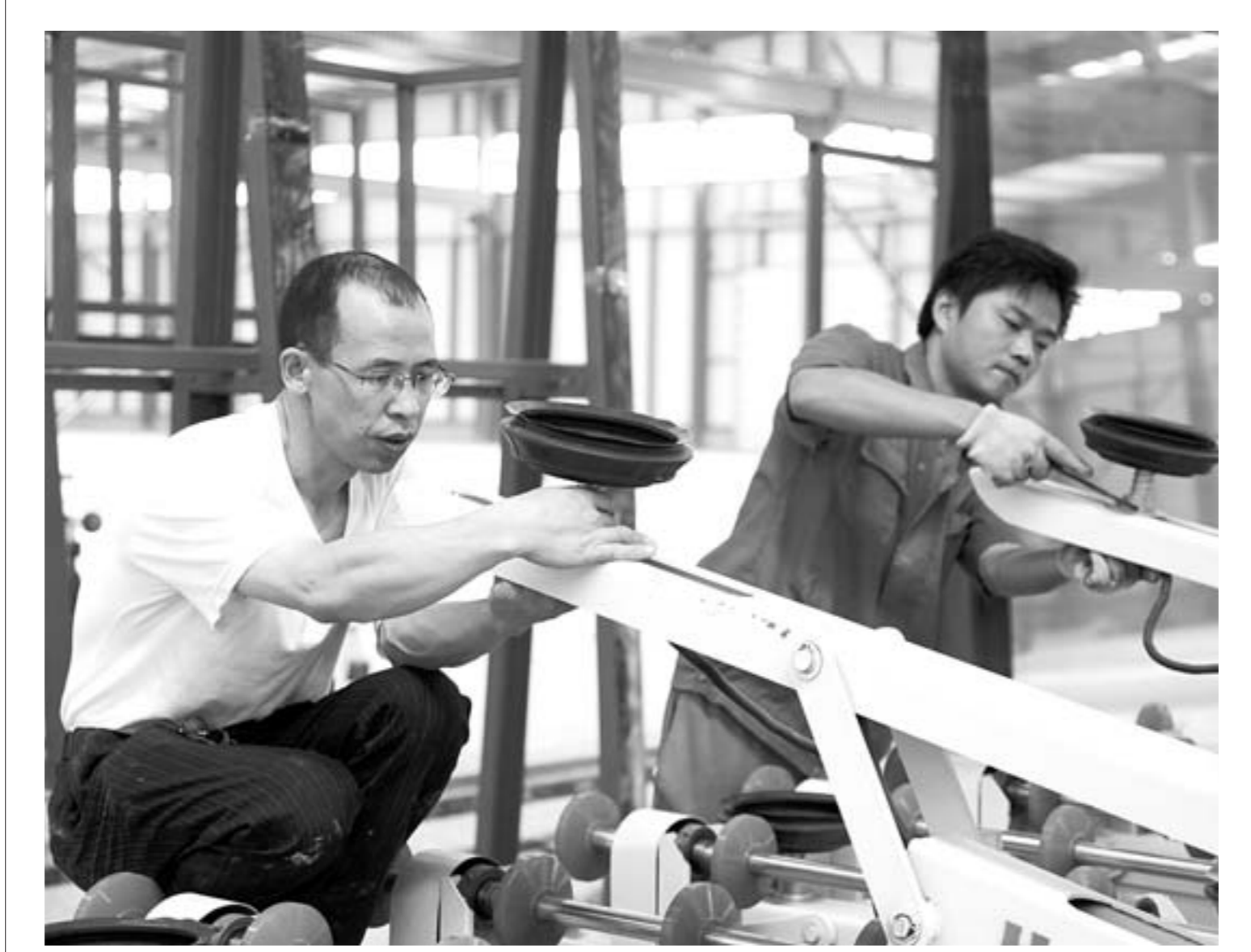
□张学荣 李辉 报道 7月21日，山东北玻玻璃科技有限公司正在进行设备安装。河口经济开发区引进的年产1000万㎡节能安全系列玻璃项目，计划总投资15亿元，建设建筑节能玻璃、导电膜玻璃等4个系列22条深加工生产线。届时河口经济开发区将建成全省规模最大的节能安全玻璃产品生产加工基地。
