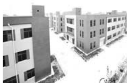
新材料交易中心一期即将竣工投产。
