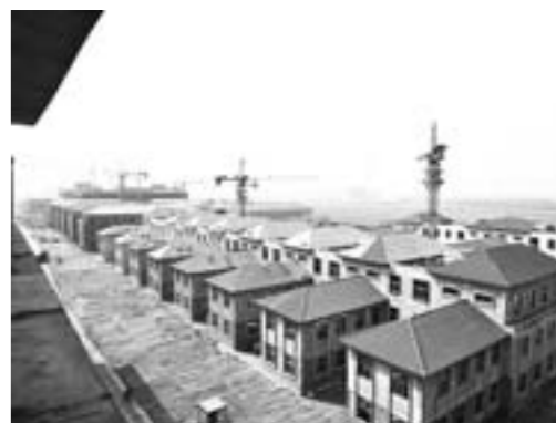
新材料产业园区正在开工建设的项目。
