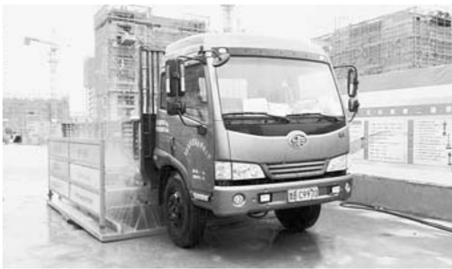
在聊城昌运莲城住宅小区施工工地,一辆运输车辆开进冲洗平台后,立时水柱喷射,将车头、车身、轮子冲了个干干净净。在许多市出台的扬尘管理办法中,都要求工地必须设置并使用冲洗设施,但自觉使用的工地并不多。
