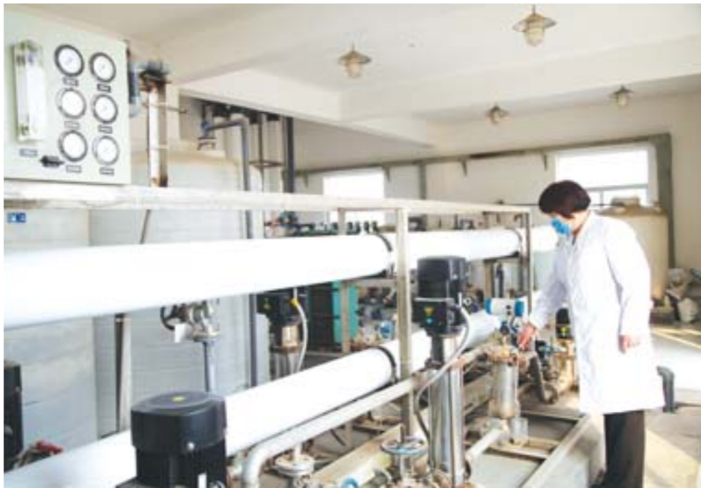
寿光垃圾处理厂的渗滤液净化设备。
