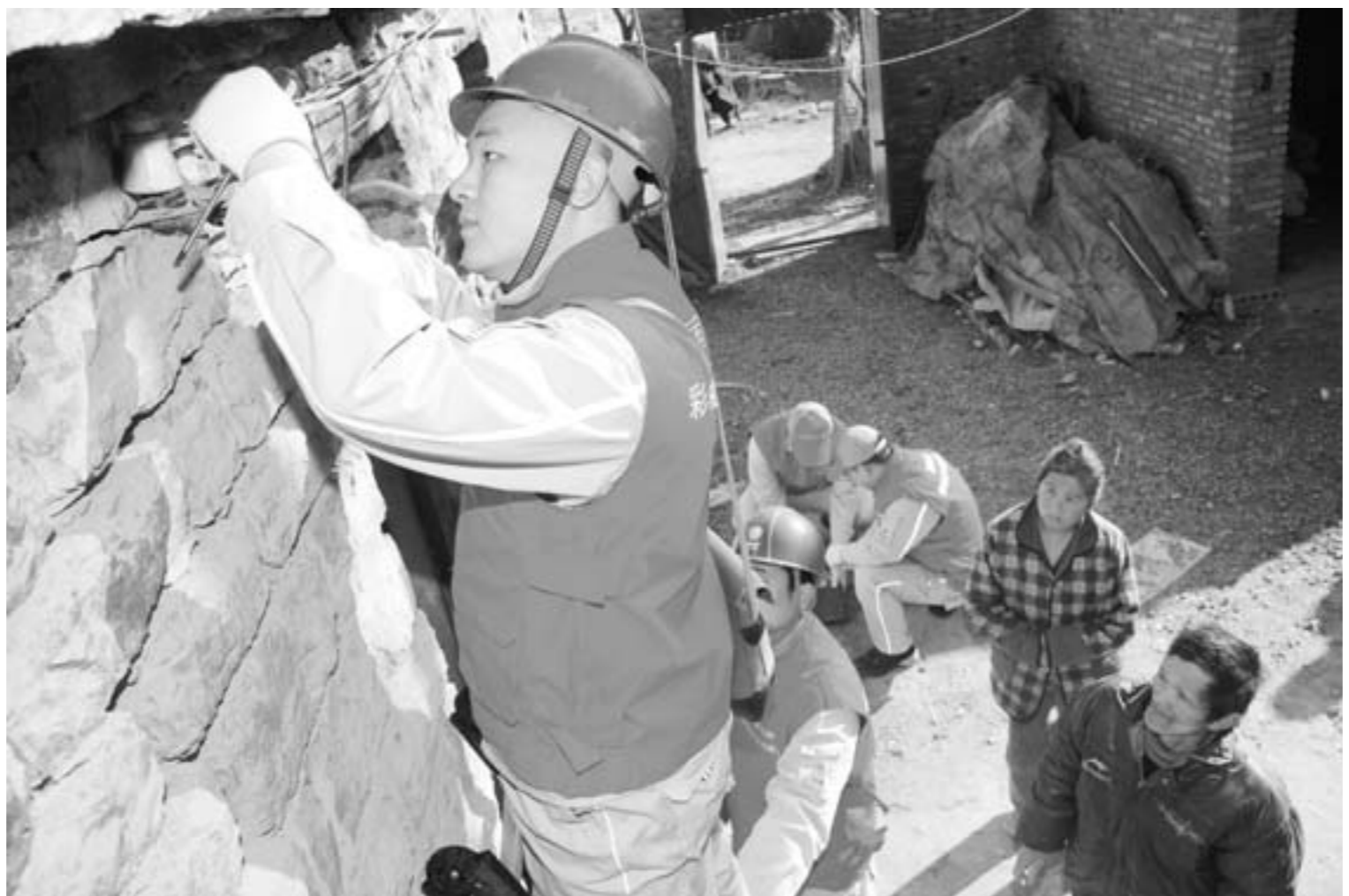
▲1月21日,国网济南供电公司开发区客户服务中心彩虹党员服务队队员为板桥井村的低电压线路进行现场检查。
