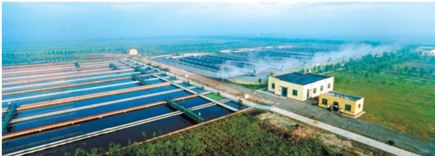
寿光城市综合污水处理厂。
