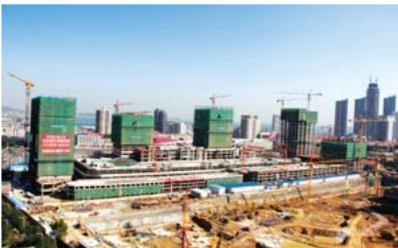
△万达城市广场项目现场一派如火如荼建设景象
