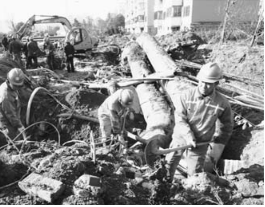
11月25日，抢险人员在青岛刘公岛路与斋堂岛街交汇处抢修供暖管线。
