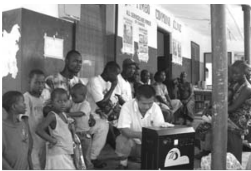
□李娜 报道 沃而丰公司技术人员正在为利比亚一诊所安装太阳能发电系统。
