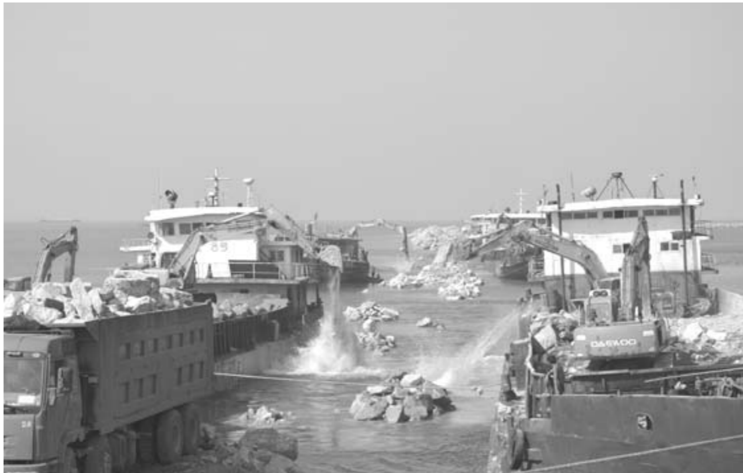
潍坊滨海港口加快建设，挖掘机正从运石船上装卸石方。如今以港口物流为代表的服务业正快速发展。
