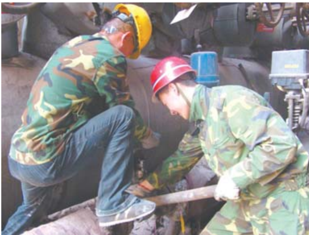
工作人员正在检修供暖设备。
