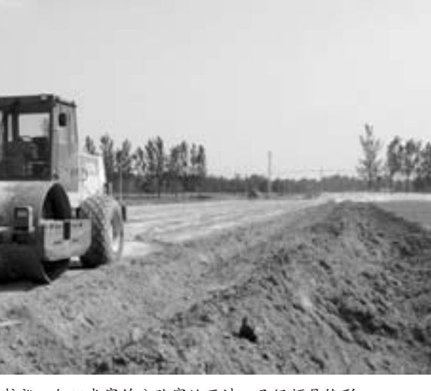
尽管村民不断抗议，但30米宽的公路穿地而过，已经颇具雏形。 □ 记者 肖芳 报道
