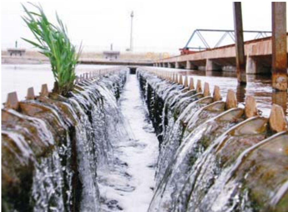
经二沉池处理后的废水, 可以直接排放, 也可作为中水回用。
