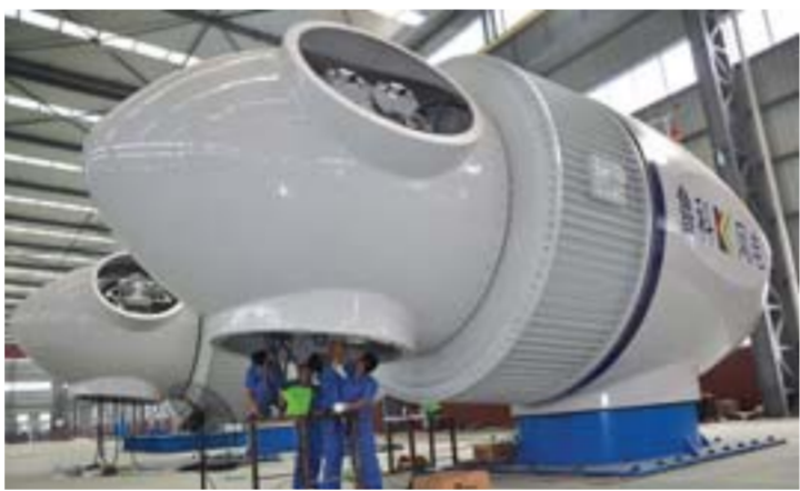
△鲁科风电设备组装现场
