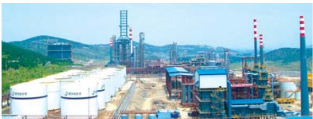
正在建设中的清沂山石化项目。
