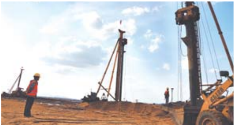
东部新区起步区内一处建设工地现场。(资料片)
