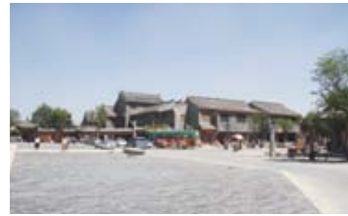
楼周边的建筑都改为青砖墙面，屋脊改为北方风格，并更换了仿古门窗。
