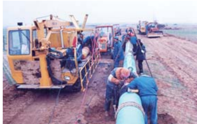
△鲁信实业集团与中石化合资建设的济南—青岛天然气管道建设工地
