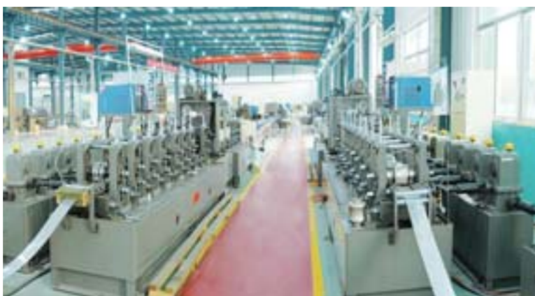
△永和铸造汽车废气循环管组装车间
