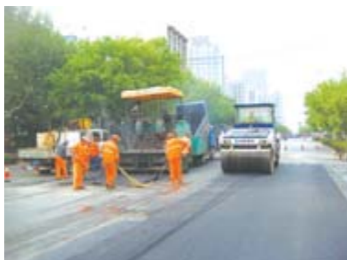
养管人员正在维护道路。
